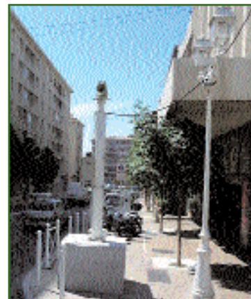
Рис. 8 Временный пилон с электронным тахеометром (Франция)
