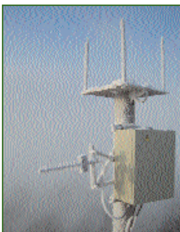
Рис. 5 Пилон спутниковой антенны АСМ моста через р. Енисей вблизи Красноярска
